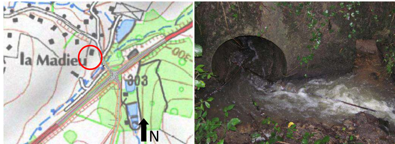
Figure 18 : Localisation de l'ouvrage (vue IGN) et vue de l'entrée de l'ouvrage
