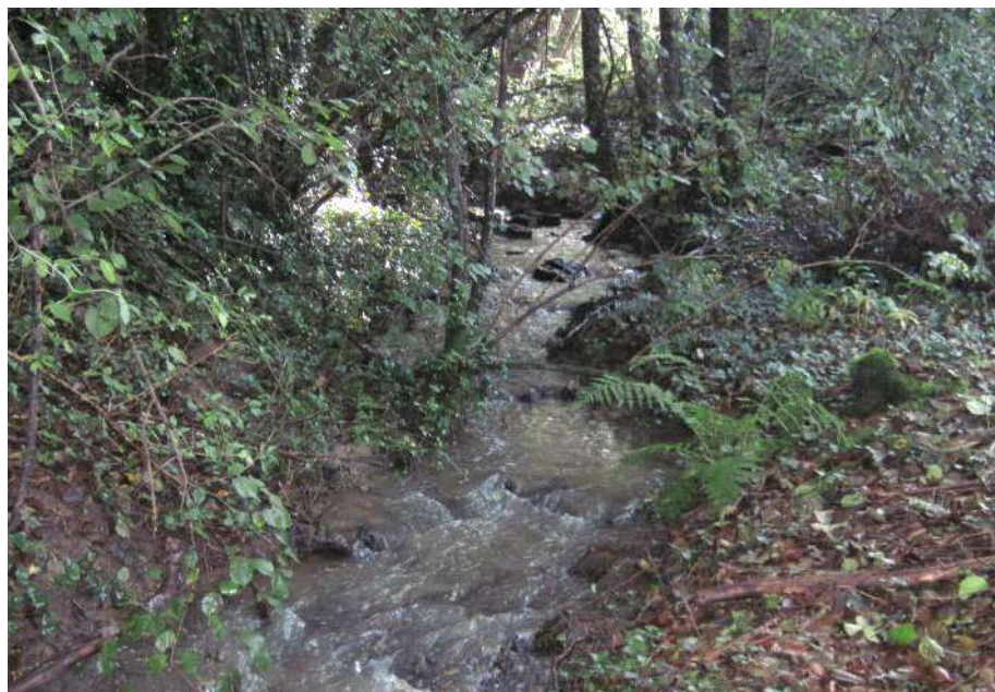
Figure 19 : Lit du ruisseau à l'amont de l'ouvrage
