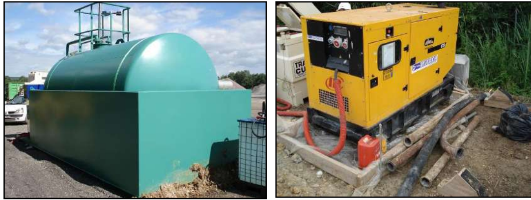
Figure 68 : Dispositifs de rétention
